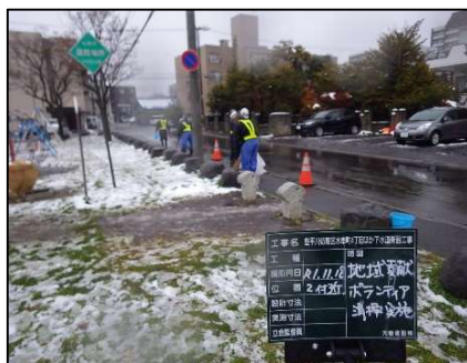
平岸3条8丁目付近での歩道清掃作業実施
