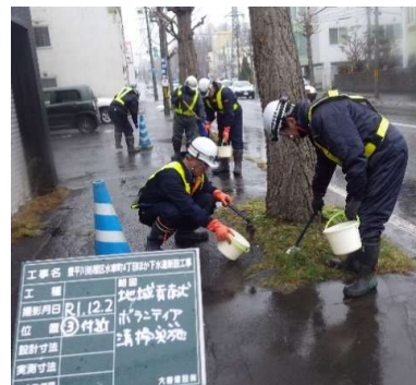
平岸6条9丁目付近での歩道清掃作業実施
