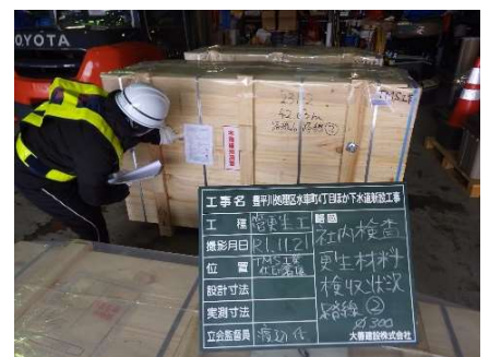
工事で使用する材料の適合検査
