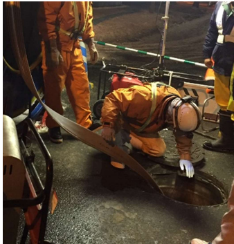
SPR施工写真
