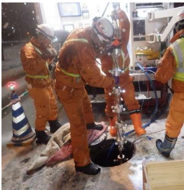
作業状況（UVライト挿入）
