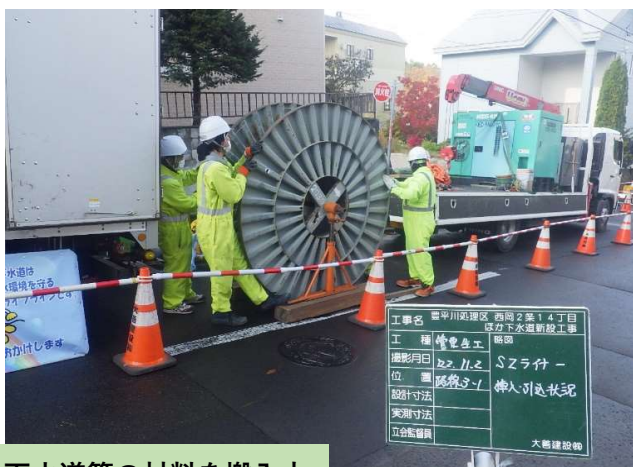
下水道管の材料を搬入中
