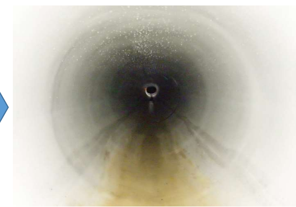
管更生施工後の下水道管
