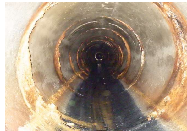
施工前の既設下水道管内
