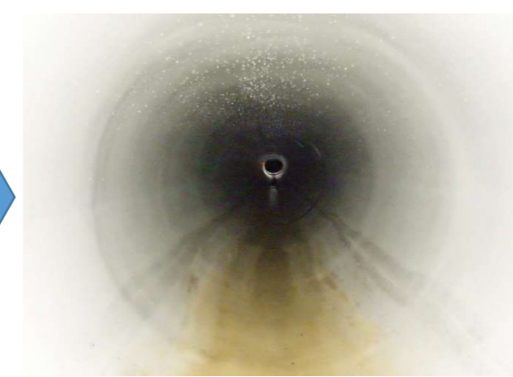
管更生施工後の下水道管
