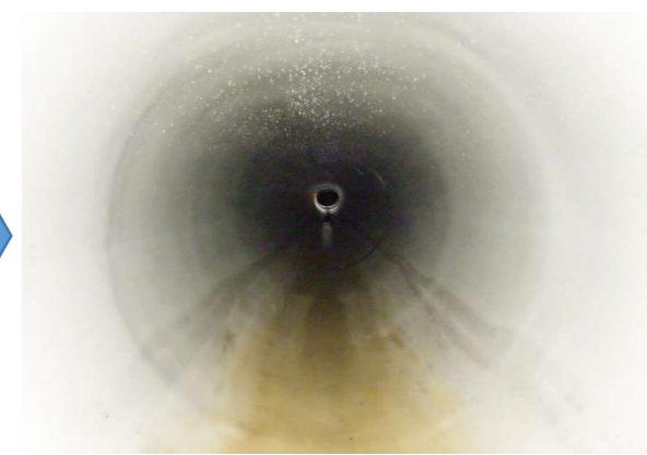
管更生施工後の下水道管
