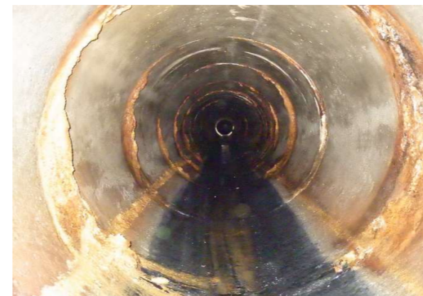
施工前の既設下水道管内
