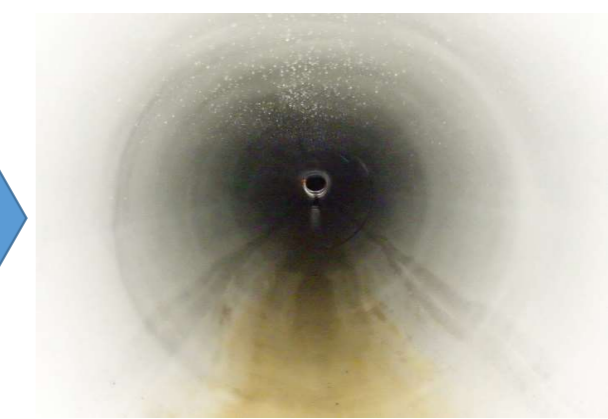
管更生施工後の下水道管
