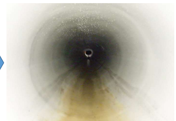
管更生施工後の下水道管
