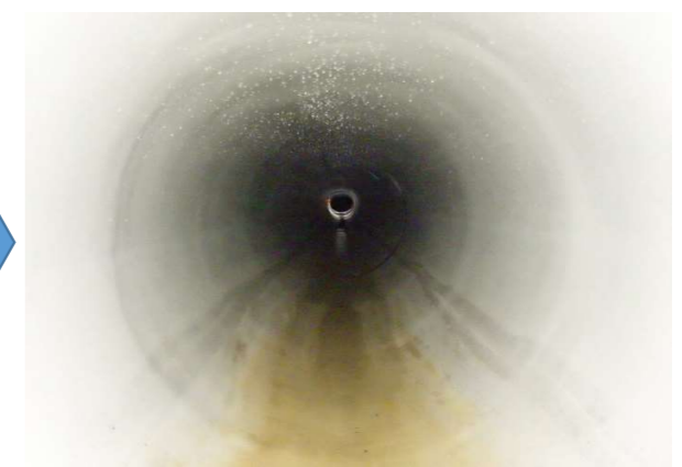
管更生施工後の下水道管
