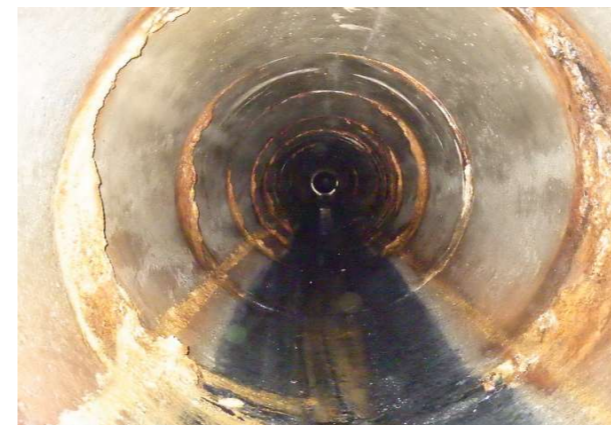
施工前の既設下水道管内
