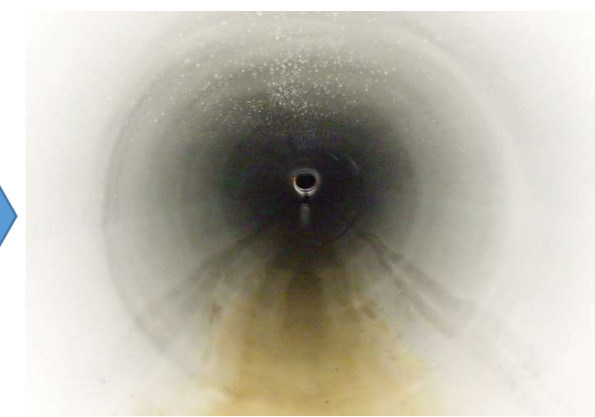
管更生施工後の下水道管
