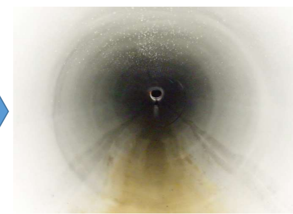
管更生施工後の下水道管
